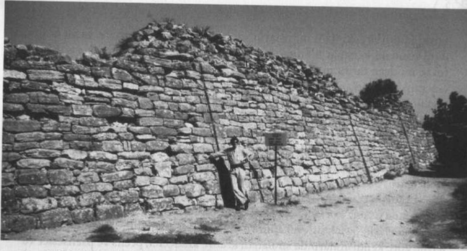
RESİM 1.2 Troia'nın şehir duvarları. Troia'daki en erken yerleşim, İ.Ö. 3000'lere kadar gider, ancak burada görülen kale duvarları altıncı yerleşim katmanında bulunur (Troia VI), İ.Ö. 1400'lerde inşa edilmiş ve İ.Ö. 1230 civarı yıkılmıştır. Düzgün kesilmiş kireçtaşı bloklarından, içeri doğru aç yapacak şekilde inşa edilen duvarlarda, ikisi kulelerle korunmuş en az dört cümle kapısı bulunmaktadır. Yunanlıların Troia Savaşı efsanelerine ilham kaynağı olan Troia, büyük ihtimalle ya Troia VI'da ya da onun daha sonraki halefi, İ.Ö. 1180 civarı yıkılan Troia VIIa katmanındaki Troia'dır. (Fotoğraf yazara aittir.)
